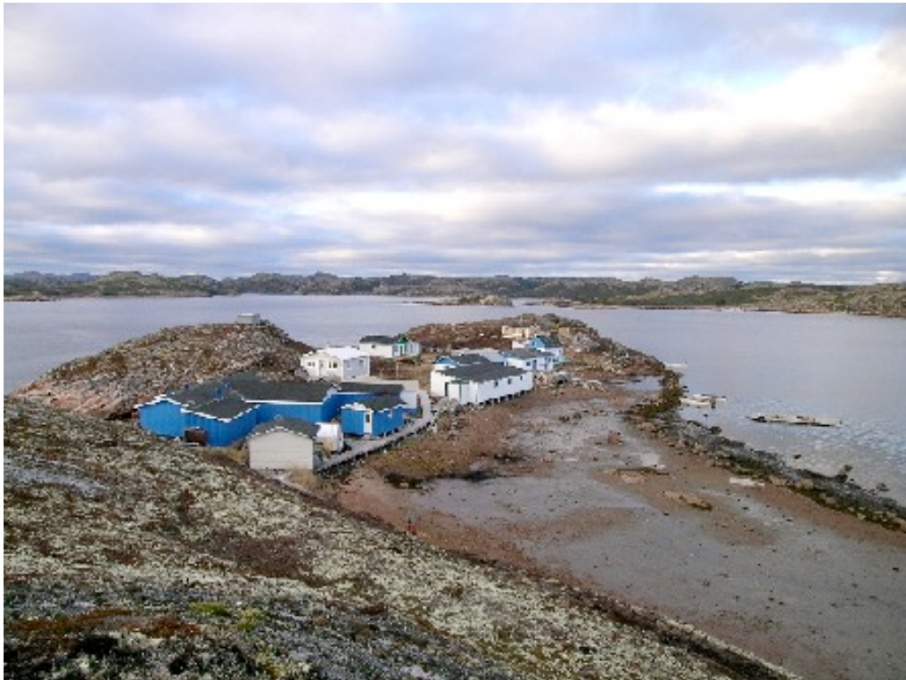
Photo 1b. Vue des installations terrestres de Pec-Nord à la Baie-Jacques-Cartier.
