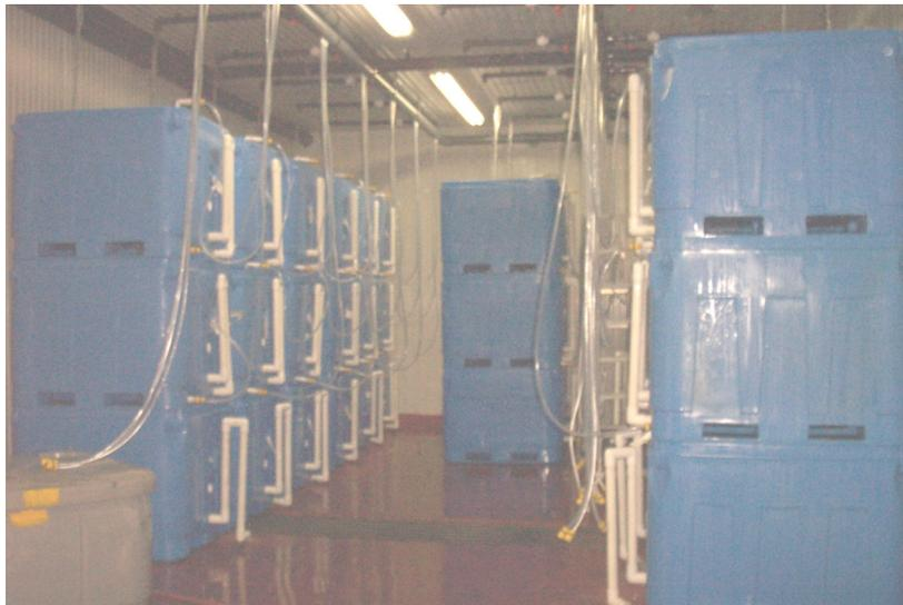
**Figure 1 : Photo de la salle d'entreposage humide et installation des bassins et des systèmes d'alimentation en eau et en air.**
