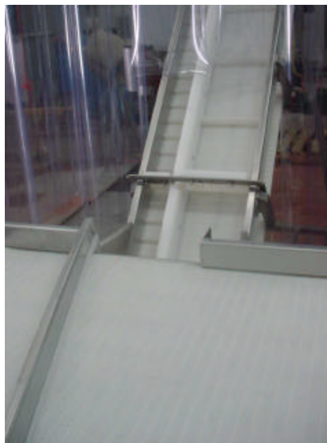
Photo 12 : Détail de la dérivation vers Extrémité de la seconde table l'ensachage et du double convoyeur d'ensachage.
