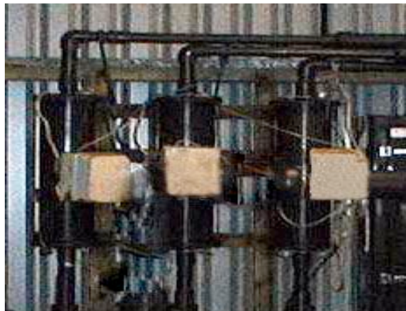
Figure 26 : A. Stérilisateur U.V. unique de grande capacité installée dans les locaux de Pêcheries Marinard et utilisé lors du projet pilote. B Unité à trois stérilisateurs U.V. utilisée à l'usine de déuration en vrac Myti Mussels homologuée par la CEFAS au Pays de Galles.
