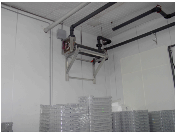
Figure 26 : A. Stérilisateur U.V. unique de grande capacité installée dans les locaux de Pêcheries Marinard et utilisé lors du projet pilote. B Unité à trois stérilisateurs U.V. utilisée à l'usine de déuration en vrac Myti Mussels homologuée par la CEFAS au Pays de Galles.
