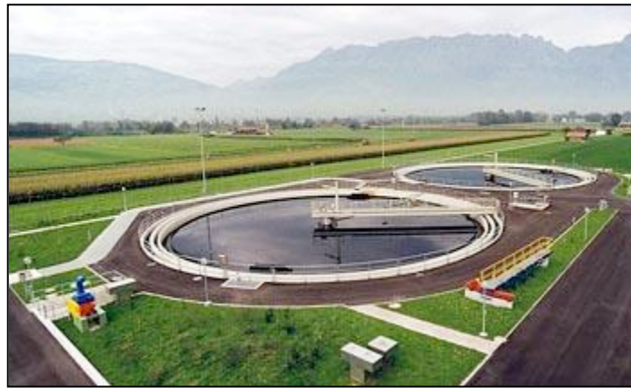
Figure 4.1 : Bassin de décantation traditionnel à Buchs en Suisse (Alpha UT, 2005)
