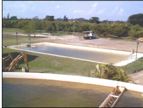
Figure 5.4 : Lit de séchage dans la ville de Miami, Floride (USA) (source : www6.miami.edu/studorgs/umfwea/davie )
